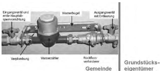
Abb: Installation Hausanschluss (Beispiel)
