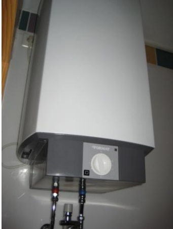
Abbildung 9: dezentrale Warmwasserbereitung
