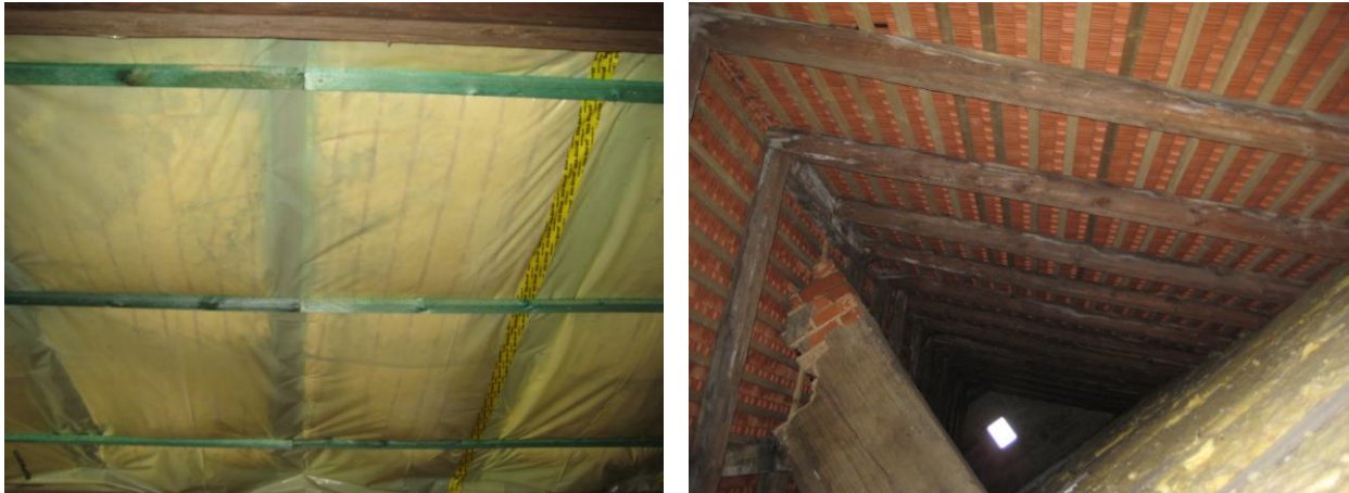
Abbildung 12: Dachdämmung 1.DG
