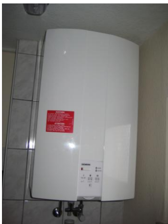
Abbildung 15: dezentrale Warmwasserbereitung
